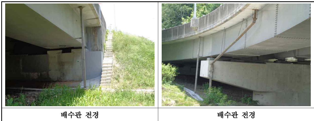
【사진 3.21】 배수시설 전경
