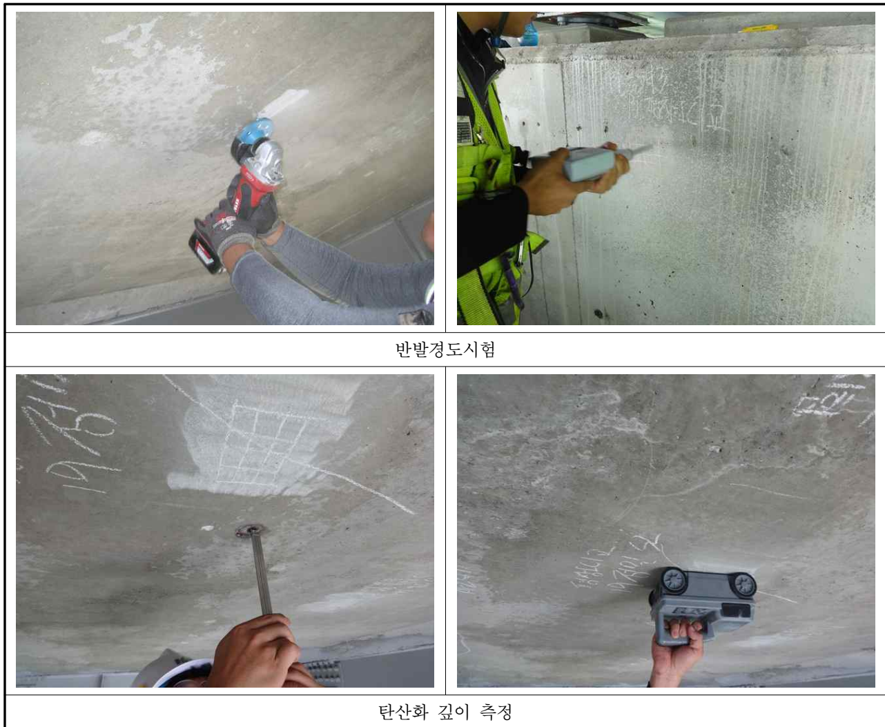
【사진 3.25】 콘크리트 내구성조사 현황
