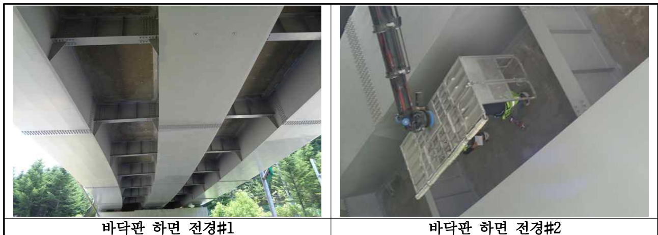
【사진 3.2】 바닥판 전경
