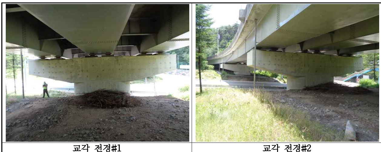
【사진 3.11】 교각 전경
