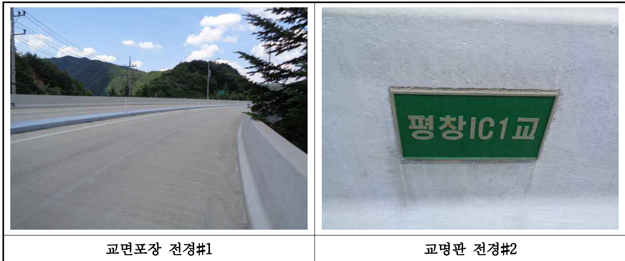
【사진 3.19】 교면포장 전경
